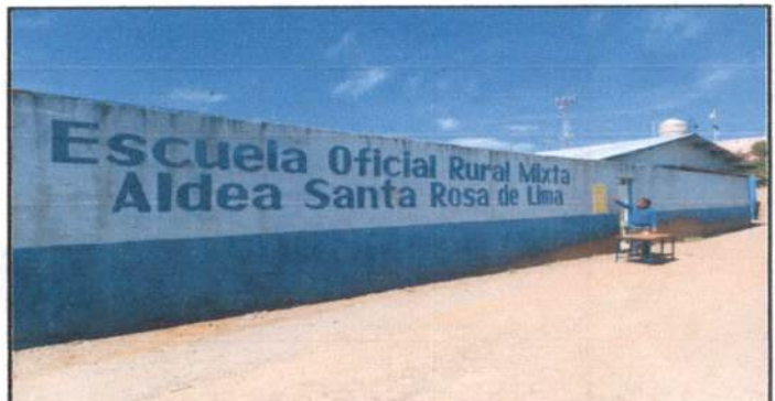
Foto 12: Sustitución de pintura interna y externa.
