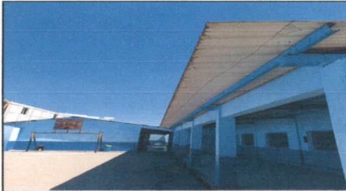
Foto 7: Sustitución de canales y bajadas de agua.
