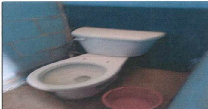
Foto 11: Sustitución de inodoro.
