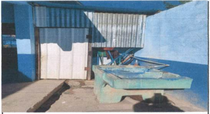
Foto 10: Sustitución de pila.
