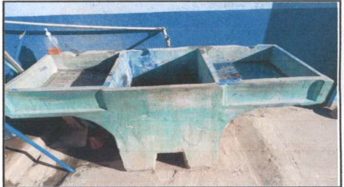
Foto 8: Sustitución de pila.
